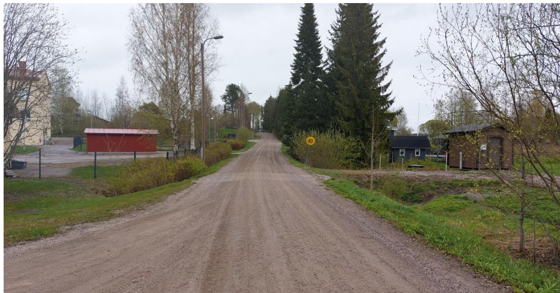
Kuva 6. Nykyinen sorapäälysteinen Aikkalantie lännestä itään katsottuna. [Ramboll 14.5.2025]
